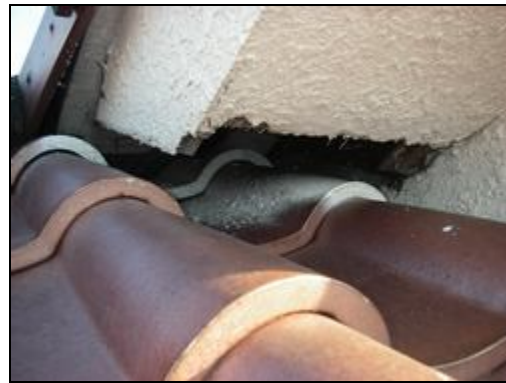
軒天井と屋根瓦の接合部
